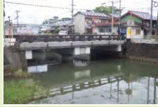
小池橋・補修補強 (東洋町)
