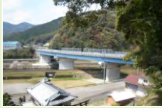
熊野権現橋耐震補強 (黒潮・国道56号)
