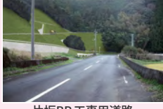
片坂BP工事用道路 (黒潮町)
