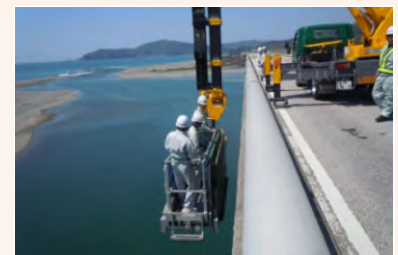
仁淀川河口大橋橋梁点検 (土佐市・高知県)
