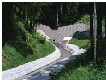
在所谷第2堰堤 (吾川郡・高知県)
