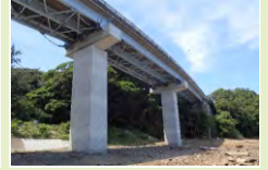
船倉橋・耐震補強 (東洋町・国道55号)
