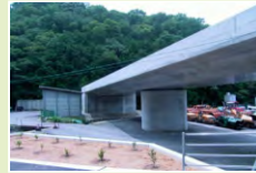
野友高架橋 (安芸・高知県)
