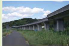
西の谷高架橋 (四万十市・中村宿毛道路)
