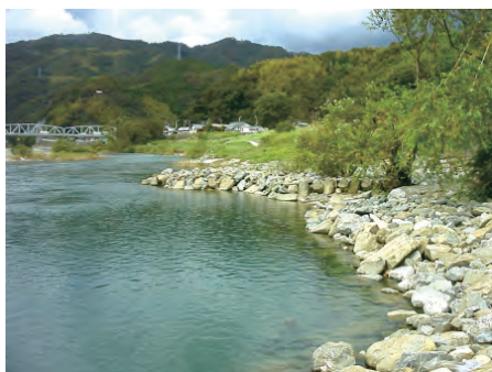
仁淀川自然石護岸 (仁淀川・高知県)
