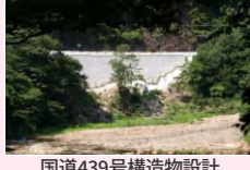
国道439号構造物設計 (四万十町・高知県)
