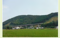
伊達野高架橋 (伊達野・高知南国道路)
