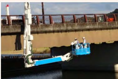
雄幸大橋橋梁点検 (五台山・高知県)
