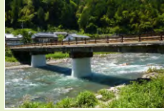
中央橋・補修補強 (馬路村)
