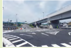
天神高架橋・ランプ橋 (いの町・高知西BP)
