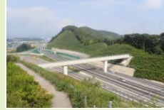
伊達野跨道橋 (伊達野・高知南国道路)
