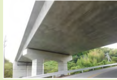
須川谷橋 (芸芸・南国安芸道路)
