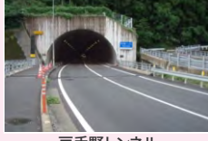
戸手野トンネル (大豊町・国道32号)
