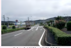
高知東道路・道路設計 (国道32号)
