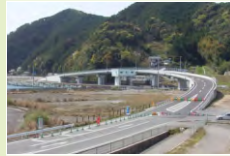
須崎港橋梁 (須崎・高知県)
