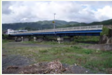
羽根川橋床版打換・主桁補強 (羽根・国道55号)
