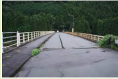
本山東大橋橋幅橋 (本山・本山町)
