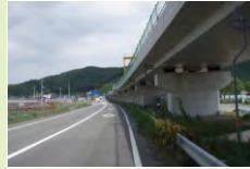
池ノ内高架橋 (須崎・須崎道路)
