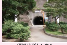
須崎歩道トンネル (須崎市・国道56号)
