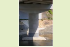
小才角橋耐震補強 (大月・高知県)
