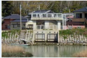
新川川樋門 (春野町・高知県)
