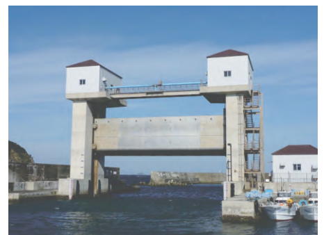
伊島漁港防波堤水門 (伊島・徳島県)
