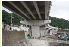
加領御橋・橋脚補強 (室戸・国道55号)
