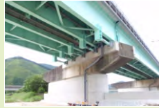
新宿毛大橋耐震補強 (宿毛・国道56号)
