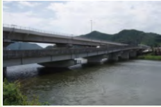
桐間高架橋 (須崎・須崎道路)
