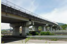
土崎跨線橋 (新設・耐震補強) (須崎・高知県)
