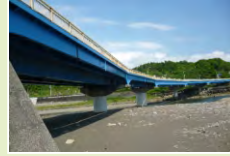
安田川橋・耐震補強 (安田・国道55号)
