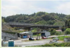
鎌田高架橋 (いの町・高知西BP)
