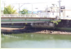
丸池橋・耐震補強 (札幌・高知市)
