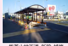
能茶山地下道・新設・補修 (高知市・土佐道路)
