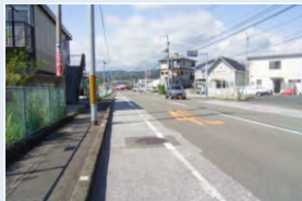
大津地区下水整備 (大津・高知市)
