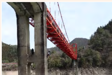
魚梁瀬大橋橋梁点検 (馬路村・高知県)
