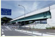
枝川高架橋 (枝川・高知西BP)
