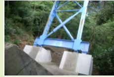
大坂谷橋耐震補強 (久礼坂・国道56号)
