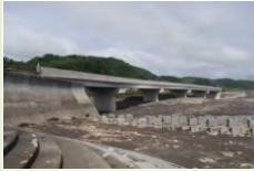
元川大橋 (室戸・国道55号)
