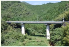
市野瀬橋床版・橋脚補強 (黒潮・国道56号)
