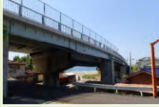
浮津側道橋 (黒潮・国道56号)
