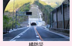
橋防災 (仁淀川町・国道33号)
