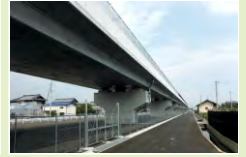
田村高架橋 (南国・高知南国道路)
