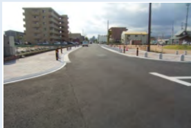
海老ノ丸地区下水整備 (海老ノ丸・高知市)
