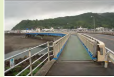
安田川橋歩道橋 (安田・国道55号)
