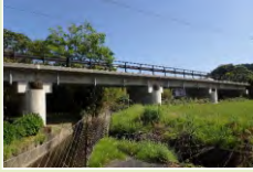
港久保橋・補修補強 (東洋町)
