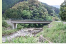
津賀谷3号橋 (中央西・高知県)
