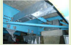
岸本橋耐震補強 (香南・国道55号)
