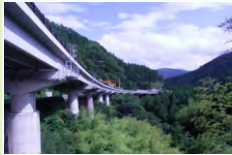
新永野橋 (橋原・地芳道路)
