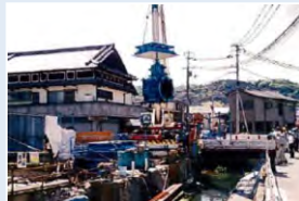
工業用水管移設 (朝倉・高知市)
